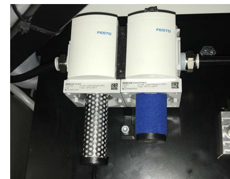
Rysunek 6-14 Filtry ze zdjętymi osłonami
