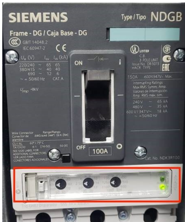
Rysunek 1-4: Główny wyłącznik AC maszyny drukarskiej
